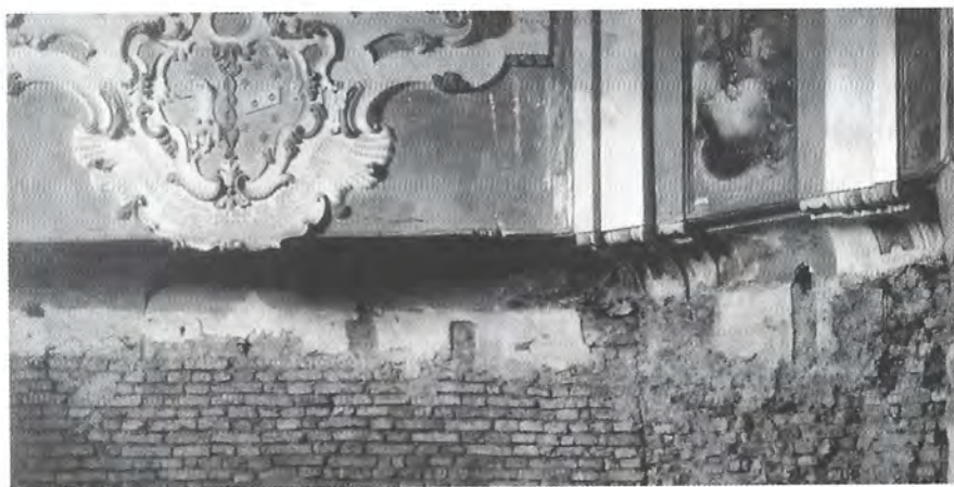
Il coro, particolare dello stemma e dell'iscrizione relativi alla pala d'altare. Si notino sulla destra una fascia dipinta, in basso lo spessore dello scasso realizzato nella parete per alloggiare gli scanni. (ASDMn, Fondo Menna, Cassa 3, b. 4).
