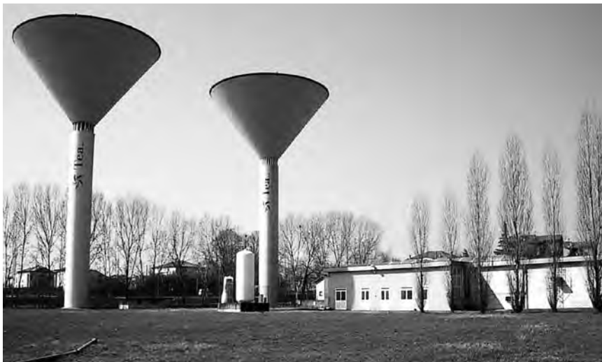
Fig. 1 - Serbatoi piezometrici nel campo acquifero di Borgo Pompilio.
