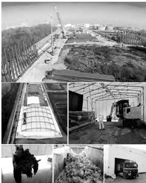
Fig. 3 - Area collina - In alto: operazioni di messa in sicurezza permanente con infissione di palancole fino a 25 m di profondità; al centro e in basso: la tendostruttura vista dall'alto e dall'interno, le operazioni di scavo, confezionamento in ambiente confinato e trasporto all'esterno dei rifiuti.
